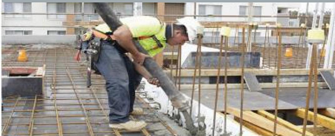
RBS profilleri istenilen uygulama için önceden kesilir ve hazırlanır, sahada gerekli işlemler RBS'in montajını yapmak ve beton dökmektir.
